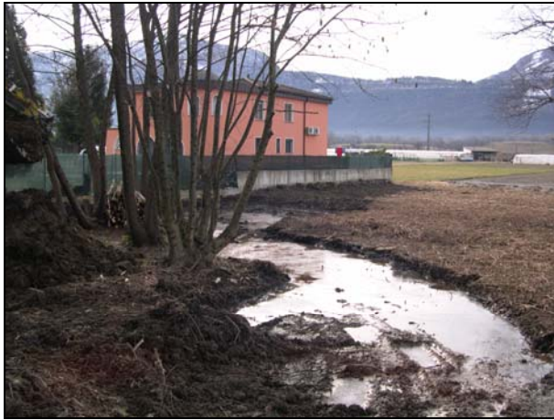
Sinistra: area scarificata, con scavo della trincea di contenimento; destra: piantumazione vegetazione concorrente.
