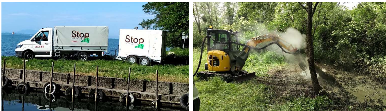
Fig. 8 Équipement pour l'injection de vapeur dans le sol (ELTEL SA, www.eltel-sa.ch ).
