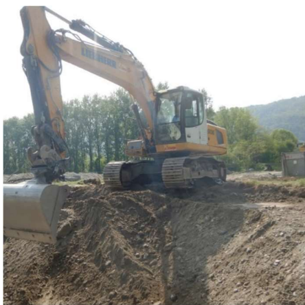
Fig. 3 Excavation d'un foyer de renouée du Japon de 200 m 2 . À droite : schéma pour l'estimation du volume excavé (400 m 3 ).
