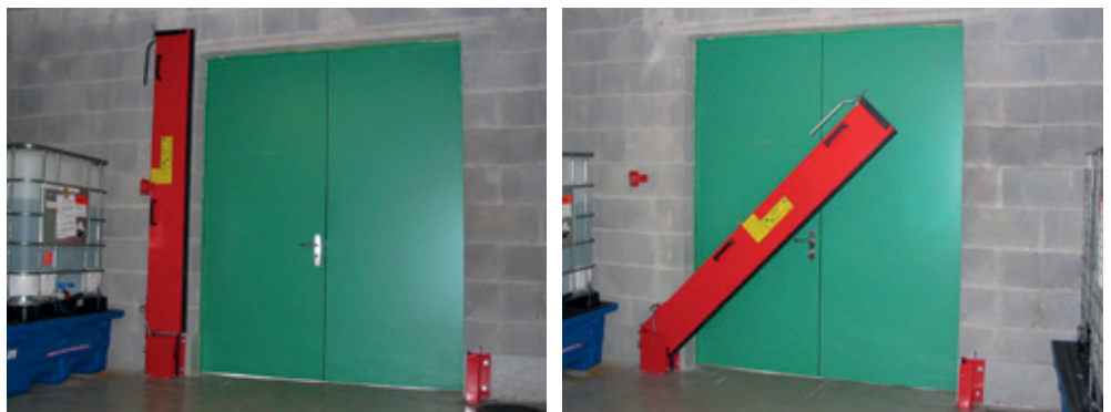
Paratia di ritenuta delle acque di spegnimento semiautomatica
