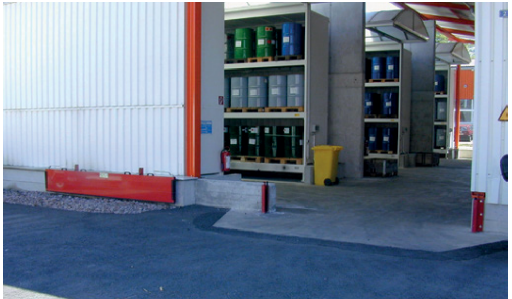
Paratia di ritenuta delle acque di spegnimento manuale
