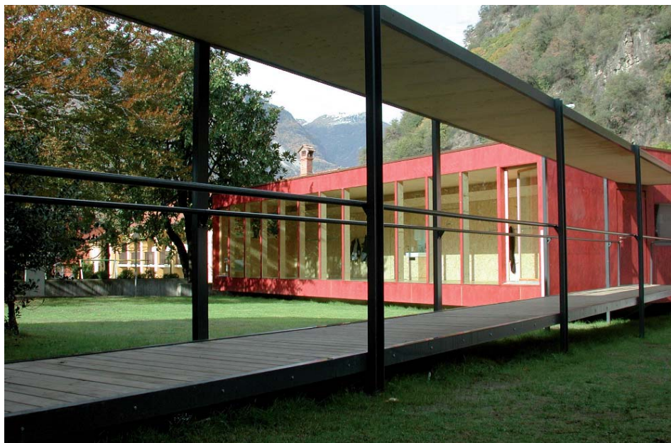
Le nuove aule della Scuola media di Castione realizzate secondo gli standard di risparmio energetico.
