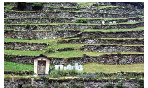
Terrazzamenti, oggetto di un progetto paesaggistico.
