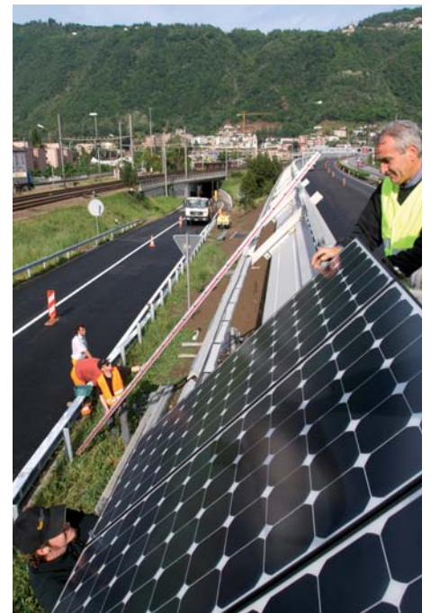
Due obiettivi con un intervento: posa di un riparo fonico sfruttato anche per ottenere energia solare a Bissone.
