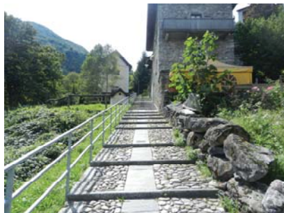
La maggior parte dei percorsi pedonali è ben attrezzata anche nel caso di importanti dislivelli.
