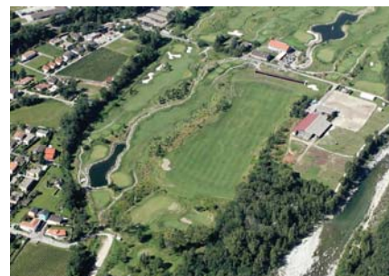
Il vasto appezzamento del centro Golf Gerre di Losone
