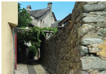
Il nucleo di Golino all'interno del perimetro dell'area. La presenza di insediamenti storici adiacenti alla zona golenale valorizza l'intero comparto.
