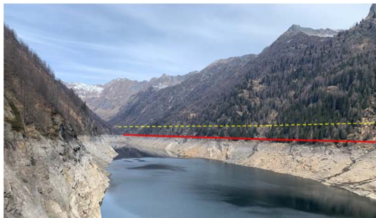
Figura 15: Tracciato attuale della strada (in rosso) e possibile tracciato futuro (in giallo)
