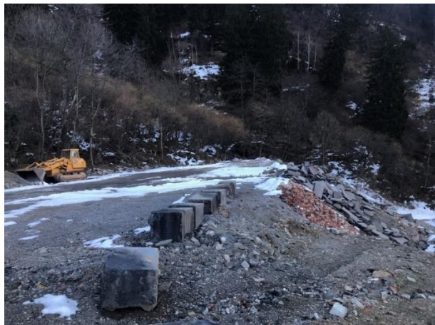
Figura 2: Seconda berma in fase realizzativa
