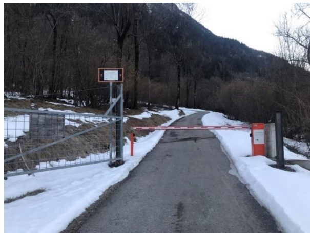
Figura 3: Barriera di accesso alla discarica
