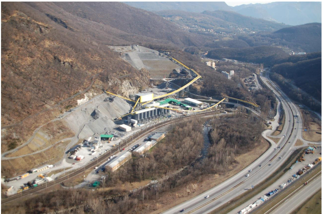
Figura 1 - Cantiere AlpTransit San Gottardo SA: attacco intermedio di Sigrino
