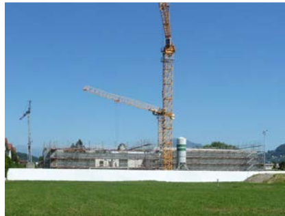
Nei pressi dell'area è in cantiere la nuova Scuola Media.
