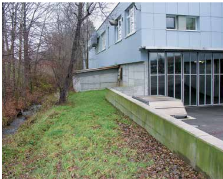
Protezione dalle piene per un deposito di prodotti chimici (Foto: Amt für Umwelt, Ct. TG)
