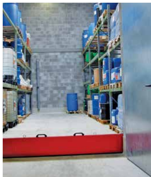
Ritenzione delle acque di spegnimento o provenienti da perdite (Foto: Amt für Umwelt, Ct. TG)
