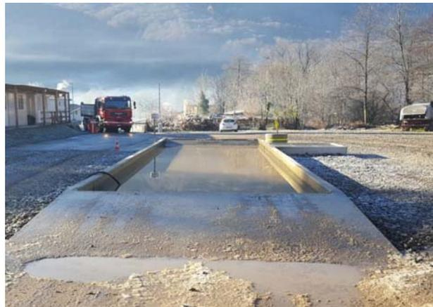
Esempio di vasca di lavaggio delle ruote (fonte URSI).
