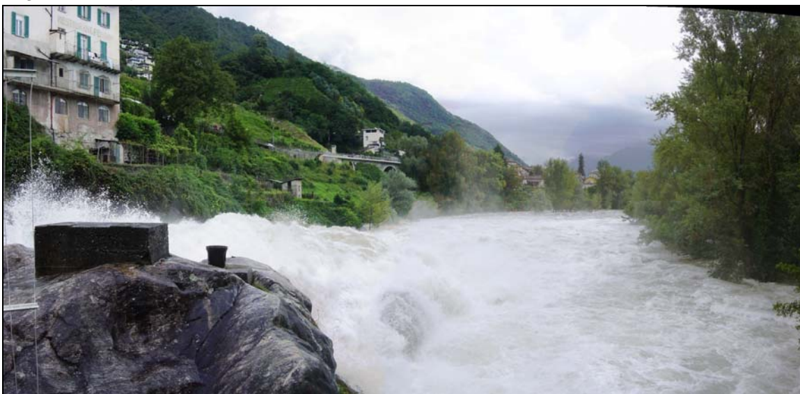
Figura 3.11 - Situazione a valle della diga, immediatamente a valle del ponte sulla strada cantonale, durante la piena di settembre del 2008, portata stimata 725 \text{ m}^3/\text{sec} .
