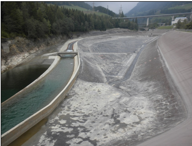
Figura 3.15 – Il bacino di compenso di Airolo durante la vuotatura completa avvenuta a fine estate 2014.
