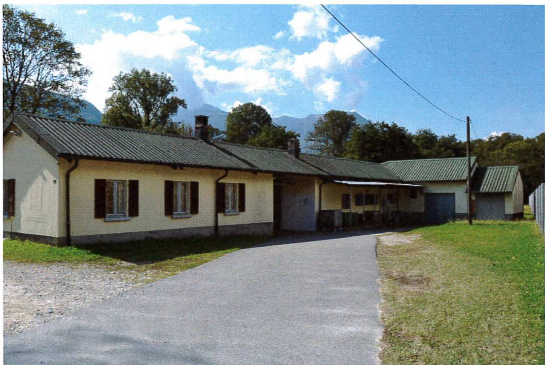
Vista da nord attuale edificio 179 A
