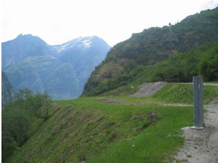
Area per le installazioni di cantiere nella zona di deposito dei materiali estratti dal bacino esistente: suolo assente su gran parte della superficie.
