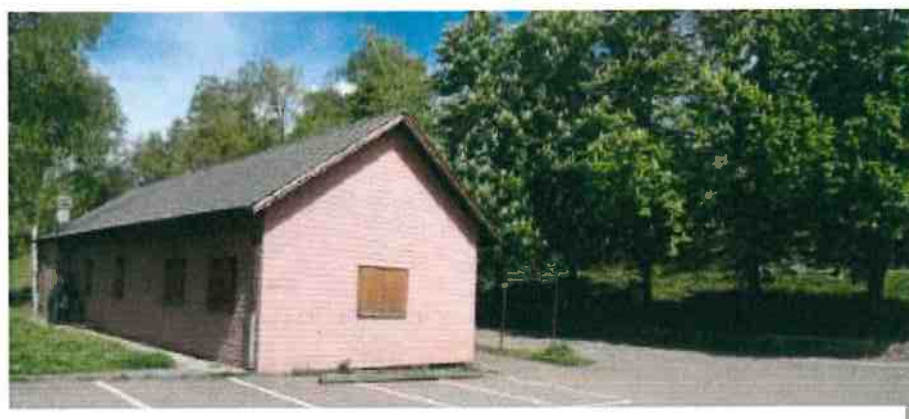
Figura 5: Cantina esistente (Lucchini & Canepa Ingegneria SA)
