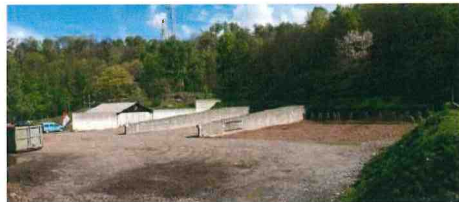
Figura 4: Impianti di tiro esistenti (Lucchini & Canepa Ingegneria SA)
