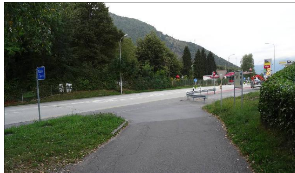
sbocco strada di servizio sulla cantonale P2 (Motto Bartola - Airola - Chiasso)
