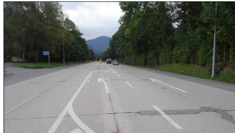
strada cantonale P2 (Motto Bartola - Aiolo - Chiasso) - vista in direzione Sud
