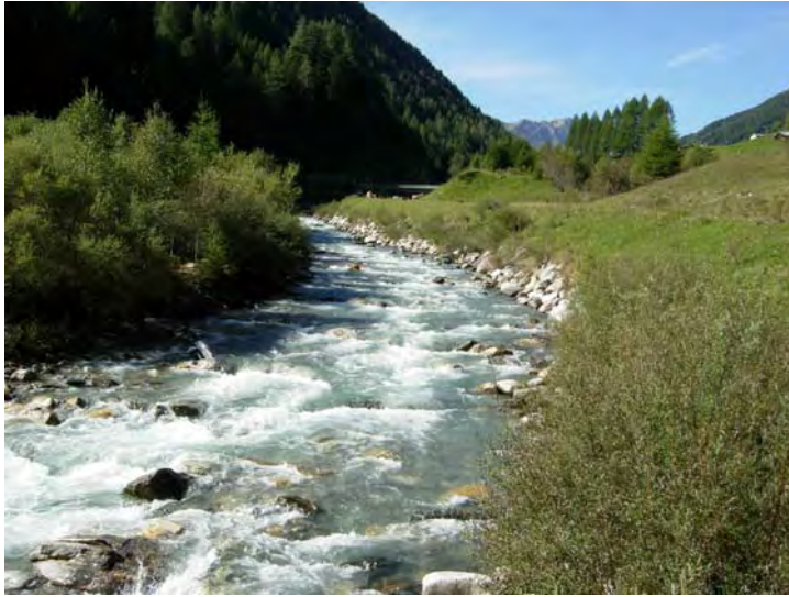
Fig. 7: Soria, arginatura lungo la sponda sinistra.
