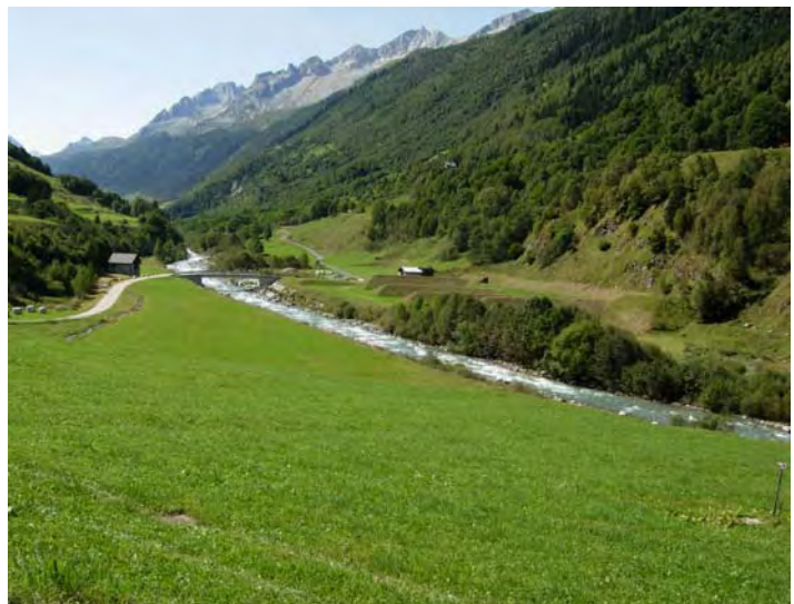
Fig. 8: Geròra, arginature lungo il poligono di tiro e la zona agricola.
