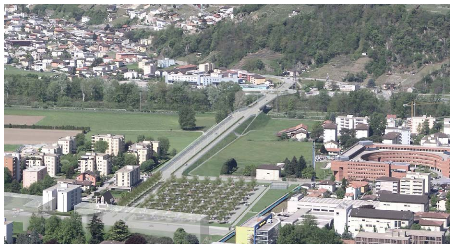
I lavori ai raccordi e al nuovo ponte stradale con vista sui nuovi ripari fonici
