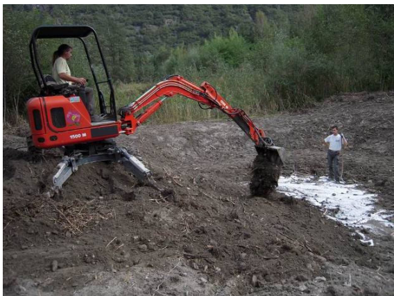
Figura 59: le operazioni di impermeabilizzazione dello stagno
