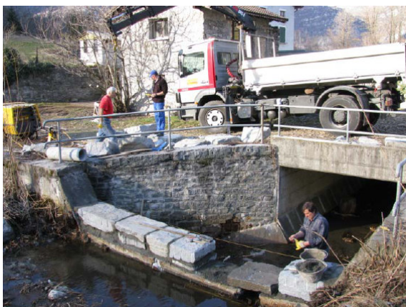
Figura 51: i lavori di innalzamento della briglia (sinistra) e dettaglio della rampa di collegamento (destra)
