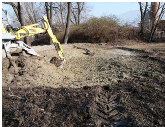
Figura 54: formazione della vasca di ritenuta (sinistra) e scavo del nuovo biotopo (destra)
