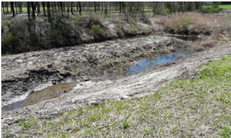
Figura 52: settore di intervento al termine dei lavori
