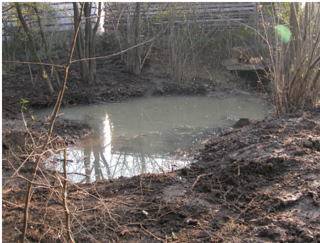
Figura 7. Stagno subito dopo lo scavo (sulla destra in secondo piano è visibile il canale sotterraneo che lo alimenta).
