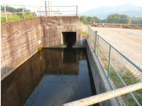
Fig. 8: Corso d'acqua intubato presso Prella
