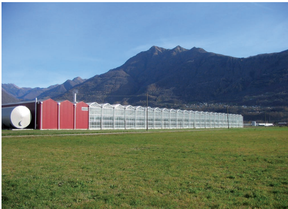
Figura 6.3 – Serre sul Piano di Magadino – Le emissioni di ossidi d'azoto del settore agricolo dovuto al riscaldamento delle serre ammonta a ca. 4 tonnellate/anno
