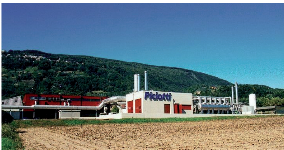
Figura 6.5 – Impianto di riciclaggio e abbattimento dei COV presso la Südpack SA (ex-Piciotti SA), Bioggio Questo impianto ha permesso di ridurre le emissioni di COV di 830 tonnellate/anno nel 2006
