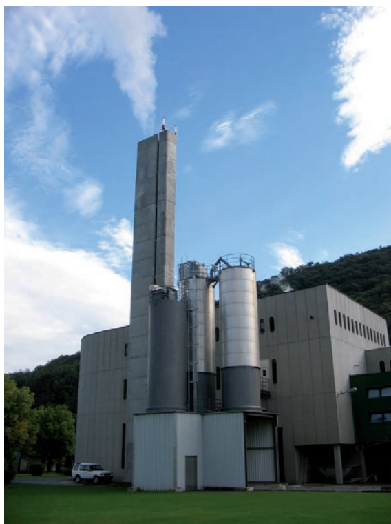
Figura 6.2 – Forno d'incenerimento dei fanghi di depurazione delle acque di Lugano e dintorni, Muzzano
