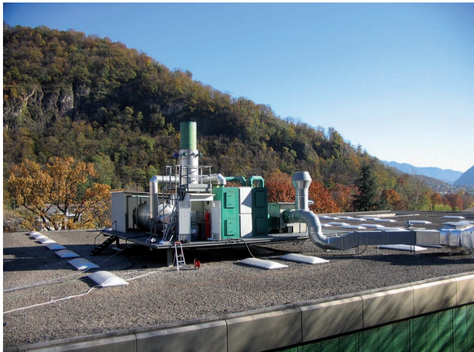
4.19 Rotoconcentratore a zeoliti presso la Osmopharm SA, a Bedano
