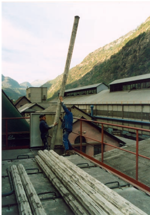
Fig. 4.11 – Sostituzione di un filtro a tessuto presso la Timcal SA, Bodio
