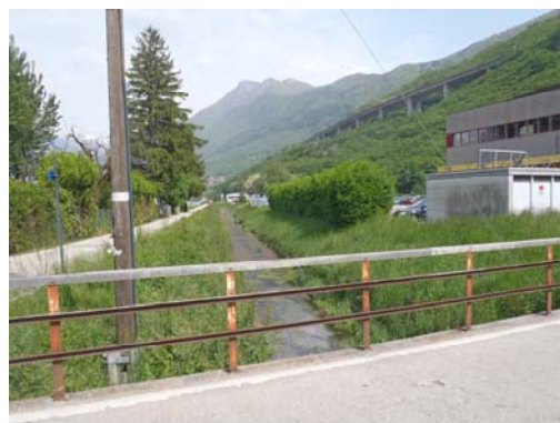
Foto 12: Canale situato in corrispondenza del tratto in trincea tra la galleria artificiale di Cadenazzo e di S. Antonino
