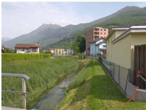
Foto 11: Canale situato in corrispondenza della galleria artificiale di Cadenazzo
