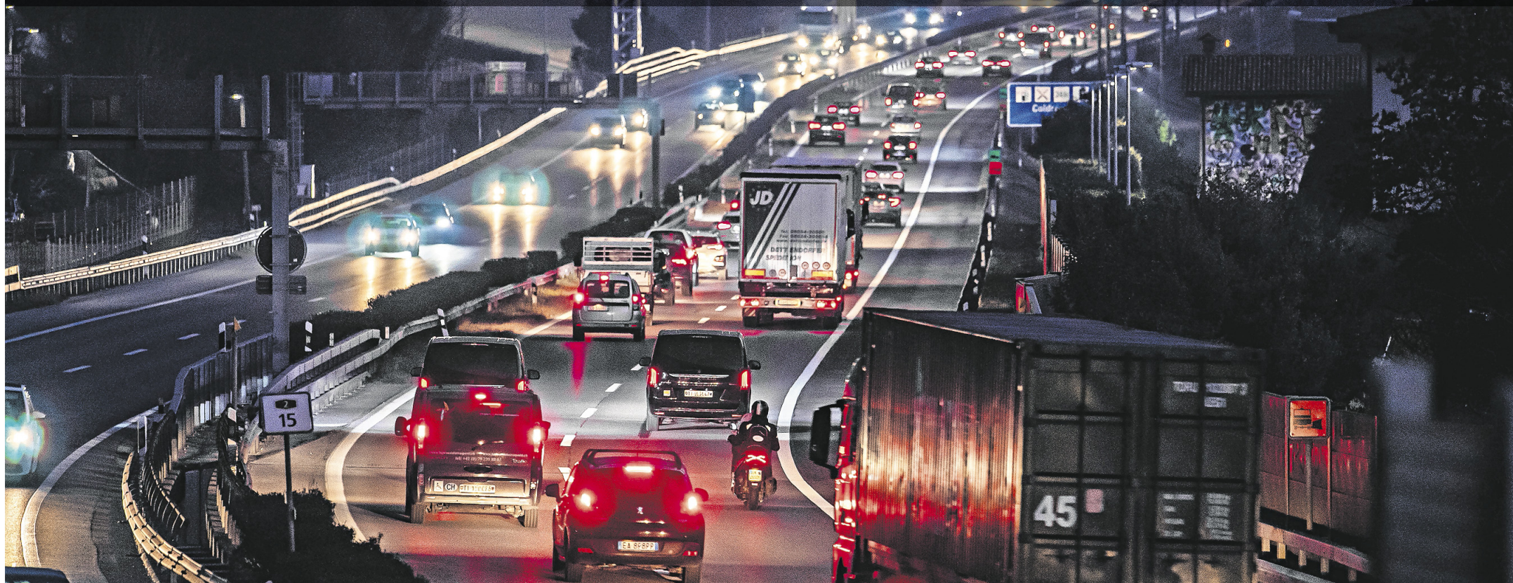
A sud del nostro cantone, uno dei tratti autostradali svizzeri giudicati più problematici.
