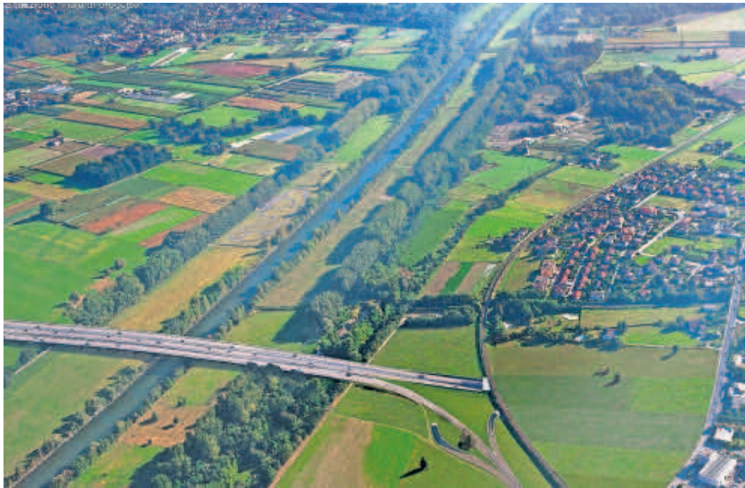
Un rendering della «bozza verde» con il ponte sul Ticino e l'entrata in galleria a Quartino.
