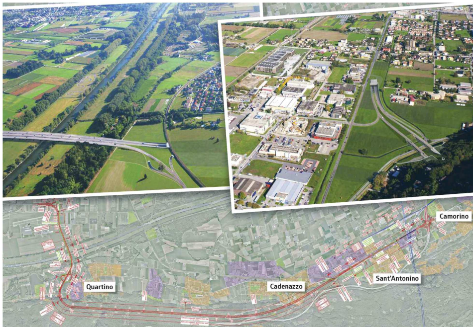
Sopra: il semisvincolo di Quartino (con galleria artificiale) e quello di Sant'Antonino. Sotto, il tracciato, in gran parte in galleria
