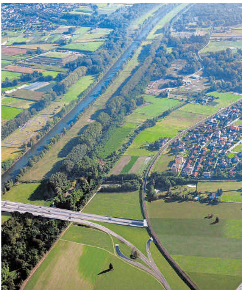
VICINI La futura galleria e, quindi, anche il relativo cantiere si troveranno a poca distanza dalla zona residenziale di Quartino. (Foto Dipartimento del territorio)
