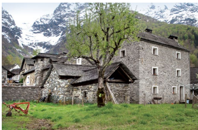
Bordei, nuovo impianto fotovoltaico situato ai margini nel nucleo
