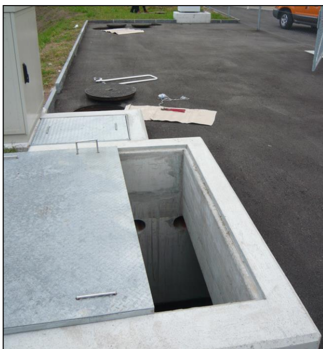
Figura 1. Esempio di cisterna sotterranea che funge da separatore di oli lungo l'autostrada
