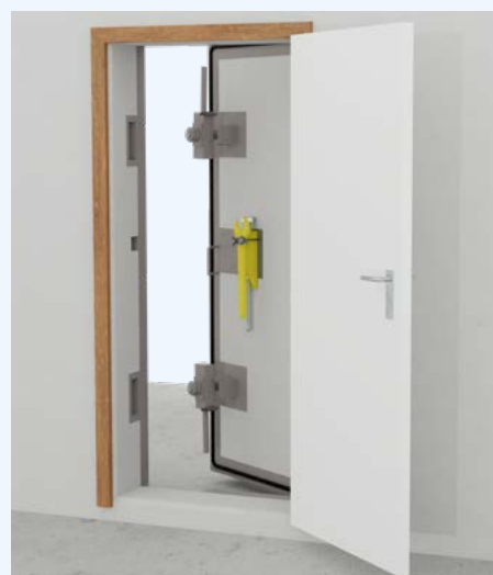
Fig. 4a/4b Durante la preparazione del rifugio si deve controllare che tutti i componenti siano presenti e funzionanti. La porta blindata permette di accedere al rifugio, ma deve anche assolvere una funzione protettiva. Prima di occupare il rifugio, bisogna smontare le porte normali.
