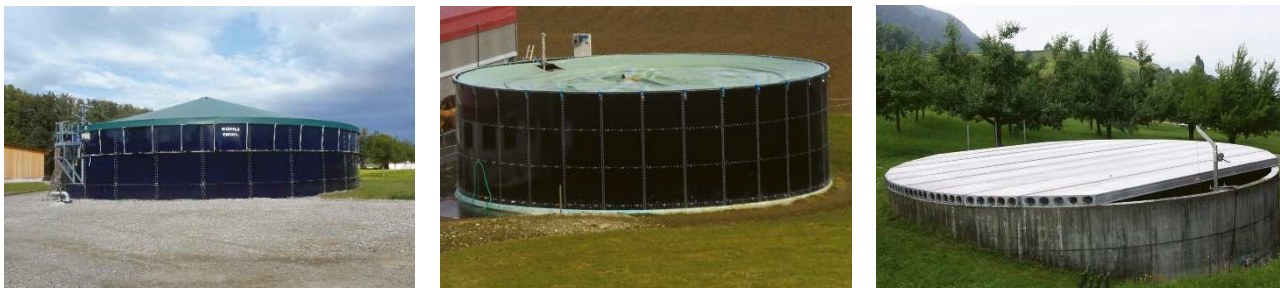
Fig. 1 Esempi di coperture (Fonte: Kohli AG) – da sinistra: copertura fissa "stile tenda"; copertura a lamina galleggiante; copertura fissa con elementi di Beton
