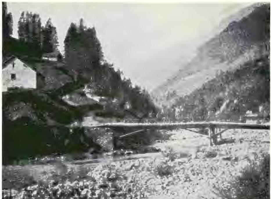
Il ponte sul Ticino che porta in valle Bedretto visto da est. In primo piano il ponte vero e proprio, che si abbassa verso il greto del fiume per permettere il transito dei carri. In secondo piano, invece, la condotta d'acqua proveniente da «Al di là dell'Acqua», costruita nell'autunno del 1874 per rifornire le fontane del paese in conseguenza della sparizione di alcune sorgenti. In lontananza, sulla pendice la frazione di Albinasca.
