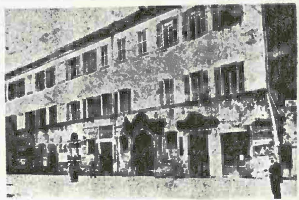
50. Il Collegio dei Remedi di Lugano
