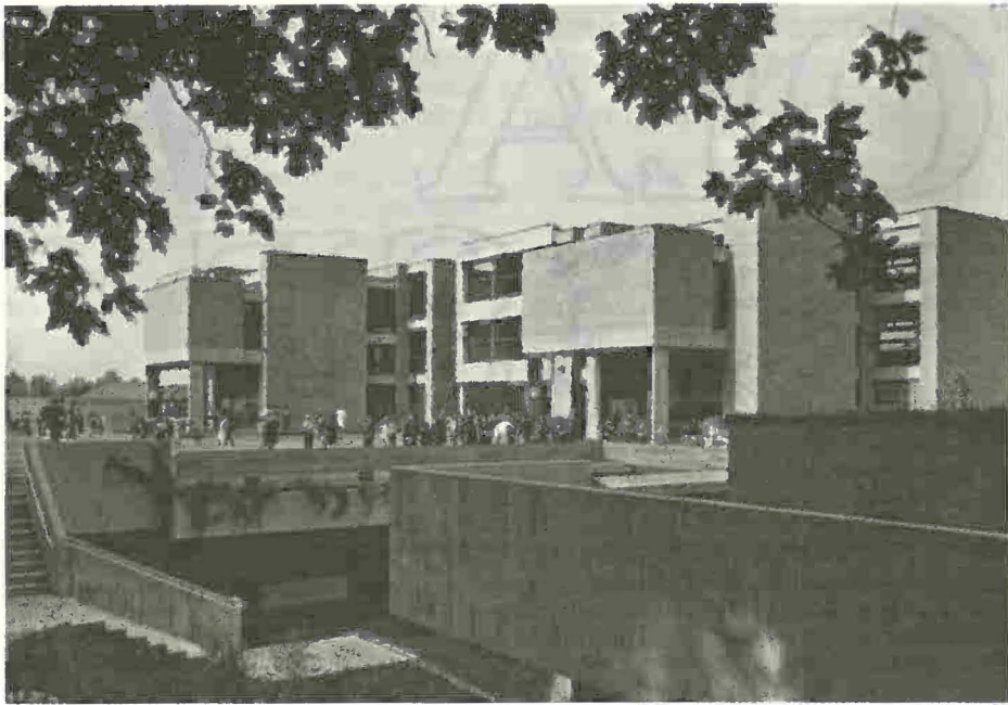
Mendrisio - Nuovo Centro scolastico di Canavee. Il complesso dell'edificio con i piazzali di ricreazione. La nuova costruzione è illustrata in un opuscolo pubblicato dall'Ufficio tecnico comunale di Mendrisio con una presentazione del direttore Giorgio Zappa, presidente della Delegazione scolastica, e dell'arch. Paul Waltenspühl, autore del progetto dell'opera. (Foto Ares, Chiasso)
