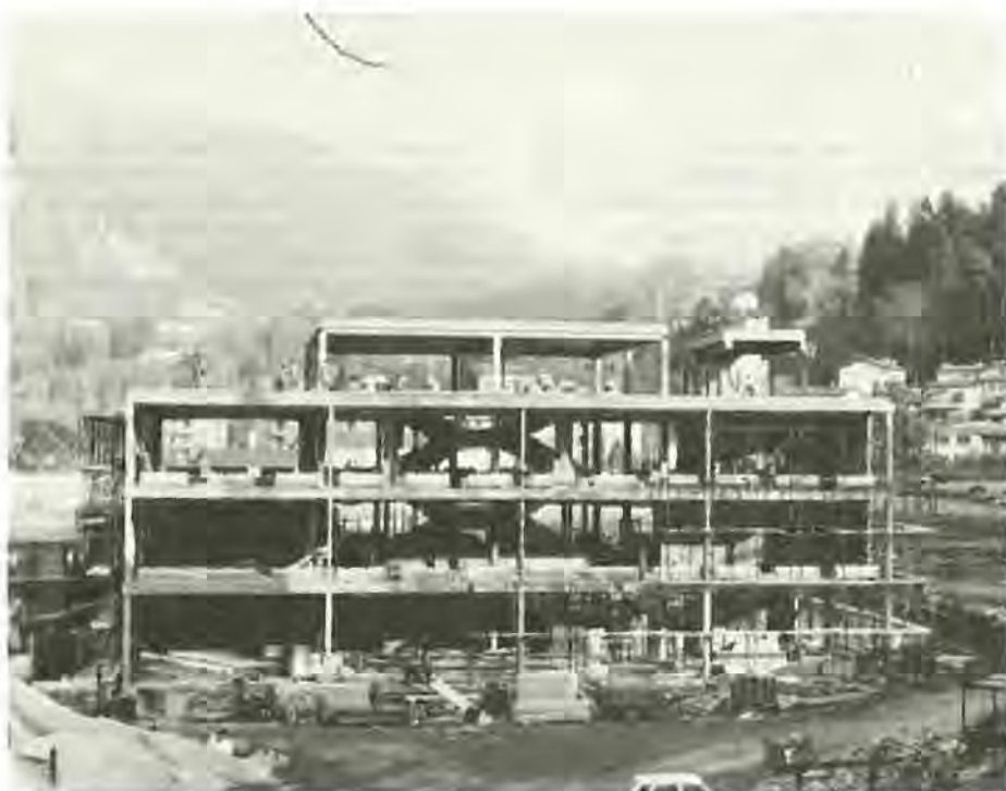
Mendrisio — La sede del nuovo Liceo in costruzione.
