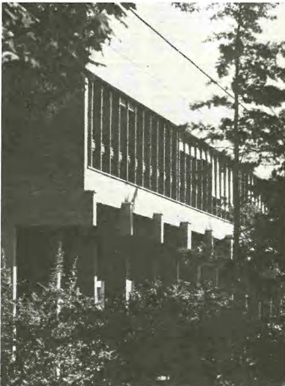
Lugano -Trevano: Scuola Tecnica Superiore
