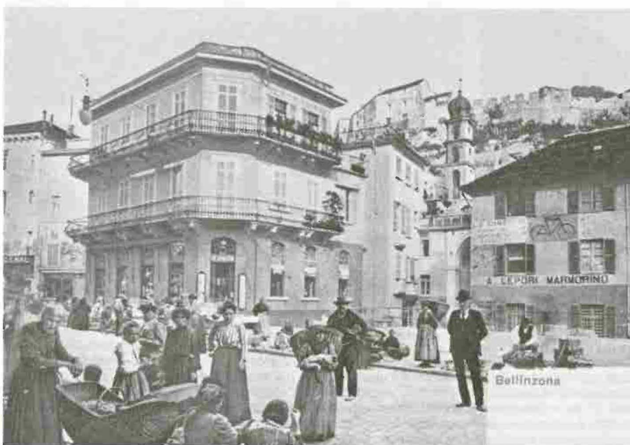
Bellinzona - Imbocco della Galleria dei Benedettini alla fine del XIX secolo. Archivio cantonale, Bellinzona
