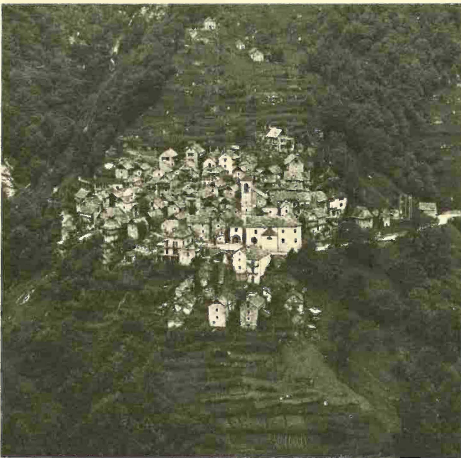
Corippo - Sul ripido pendio il villaggio di Corippo s'abbarbica con esemplare compostezza; le case si stringono intorno alla chiesa, quasi pigiate in un atto di solidarietà: e le poche che se n'allontanano, lungo i terrazzi verso la valle, tosto sembrano ritrarsi, come timorose. (da G. Mondada, «Corippo», Berna - Zurigo 1975)
