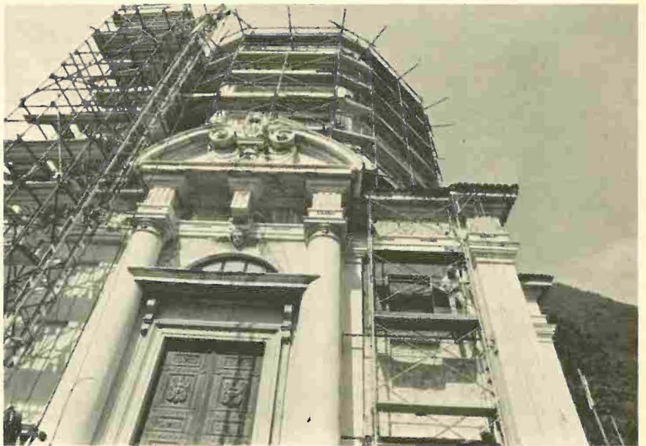
Riva San Vitale, Chiesa di Santa Croce - Particolare della facciata, durante i recenti restauri. Dal massiccio quadrato della base si passa al piano ottagonale: i modi sono insieme severi e nuovi, il rigido classicismo già prelude alle movenze e alle arditezze barocche.
