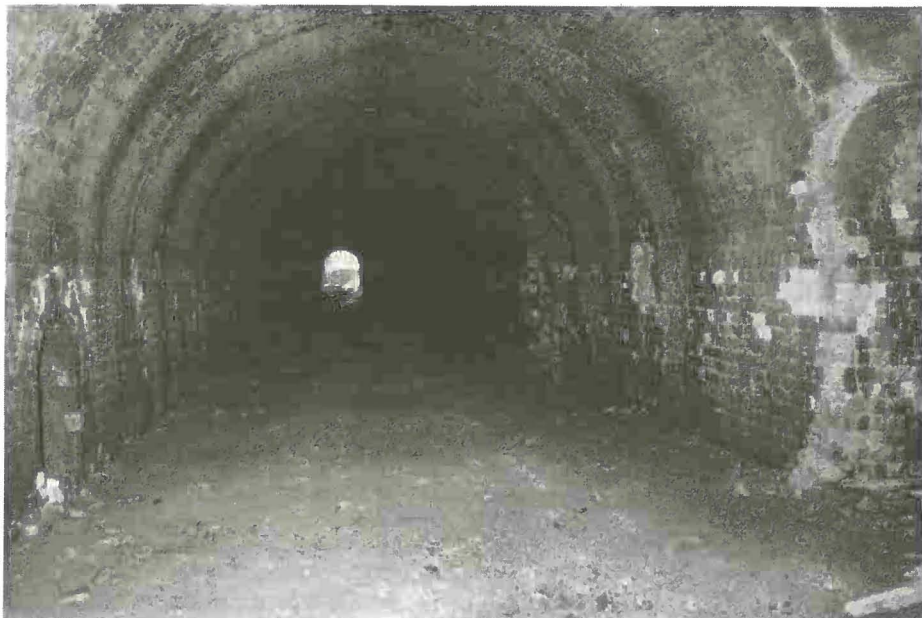
Novazzano. Fornace della Boscherina. Interno di un ramo del forno a fuoco mobile (forno Hoffmann). Foto Ufficio cant. dei musei/F. Mattei
