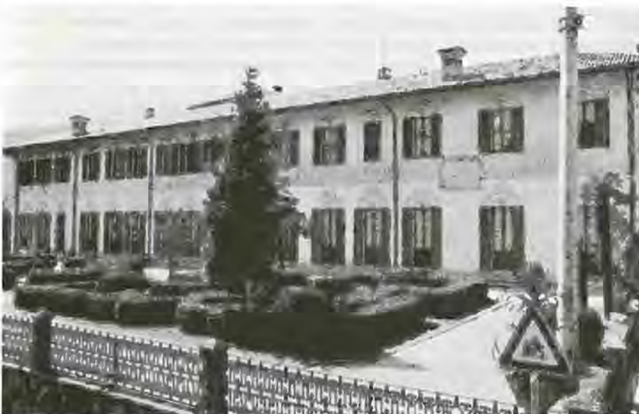
Facciata della Villa Negroni
