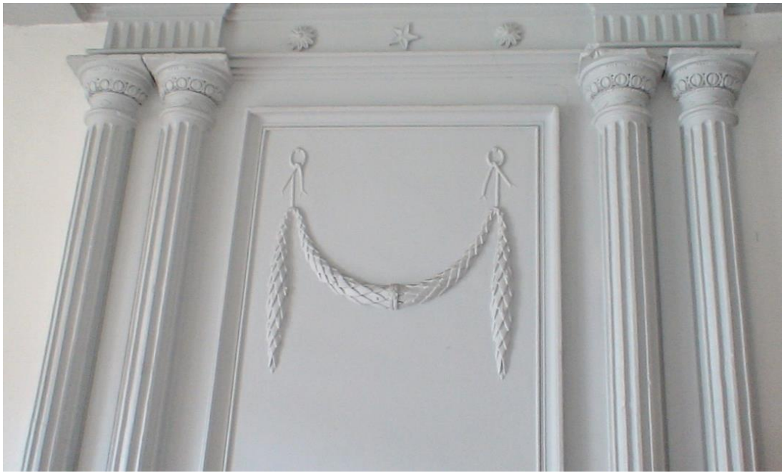
Détails du trumeau de la cheminée. On remarquera au fronton les signes du compagnonage.
